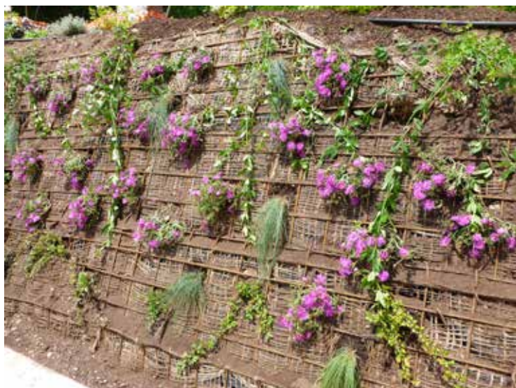
Civezzano, sistemazione dell'area intorno al monumento ai caduti: particolare dell'opera in corso di realizzazione (armatura in ferro e juta) nel giugno 2014 e del lavoro finito, nella primavera 2015
