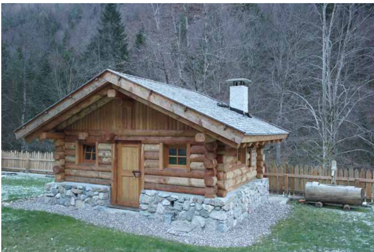
Ristrutturazione di un edificio tradizionale in Val di Tovel con contributo PSR
