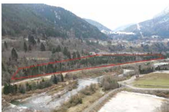
Una veduta dell'area prima dell'intervento
