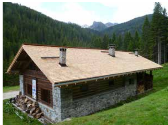
Sostituzione con scandole del manto di copertura della malga Soccede
