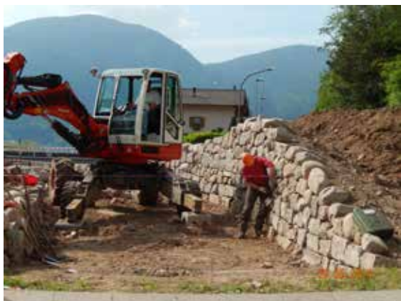
Realizzazione di verde stradale presso lo svincolo Cembra-Faver, 2014
