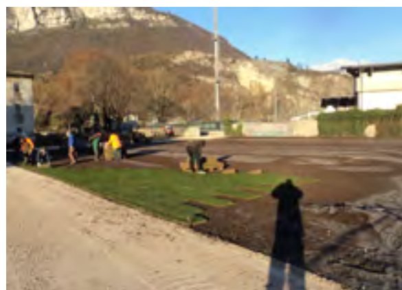
Messa in posa di prato a rotoli nell'area prospiciente il MUSE
