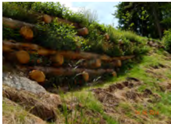
Particolare della cordonata viva nella sistemazione della sponda del Rio Sies
