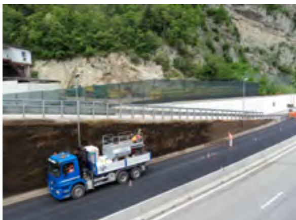
Lavori di idrosemina delle terre armate lungo la tangenziale di Trento all'uscita dalla galleria di Piedicastello in direzione Sud.
