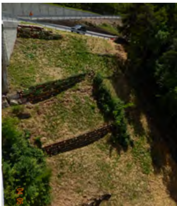
Sistemazione del dissesto della sponda del Rio Sies
