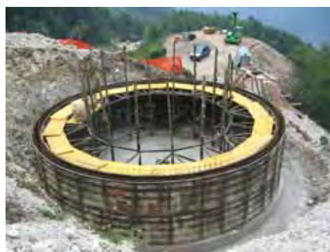
I vasconi antincendio, come questo di tipo circolare, in costruzione in Val delle Bore, rientrano fra le opere la cui progettazione è stata centralizzata
