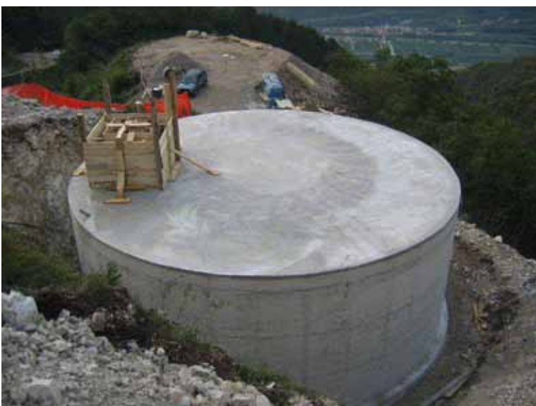
Serbatoio interrato di calcestruzzo in fase di costruzione
