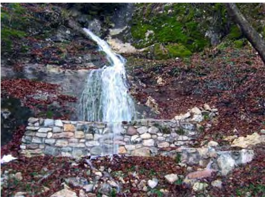
Anche la progettazione delle opere di presa viene gestita a livello centrale, questa in particolare, serve all'alimentazione di un vascone in costruzione in Val delle Bore
