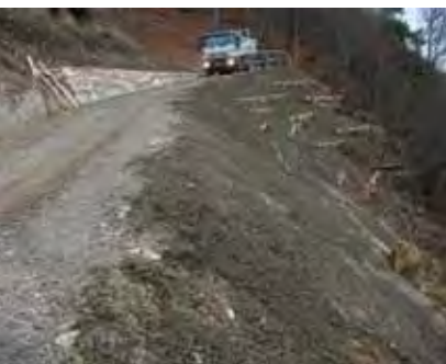
Sistemazione delle rampe lungo la viabilità forestale
