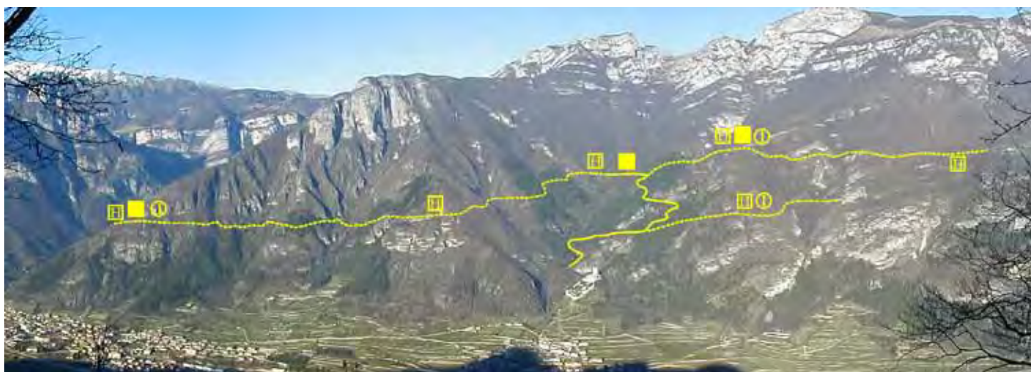
Sistema antincendio boschivo per il versante montuoso a nord di Avio
