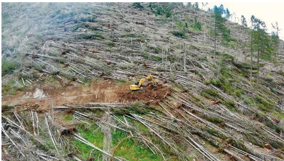
Avanzamento con macchine operatrici dotate di GPS - Comune di Moena - Strada Crepac
