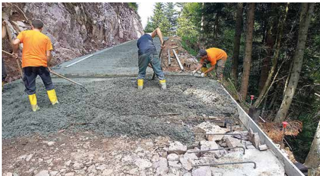
Tratto cementato per impossibilità di modificare il tracciato, con consolidamento della banchina
