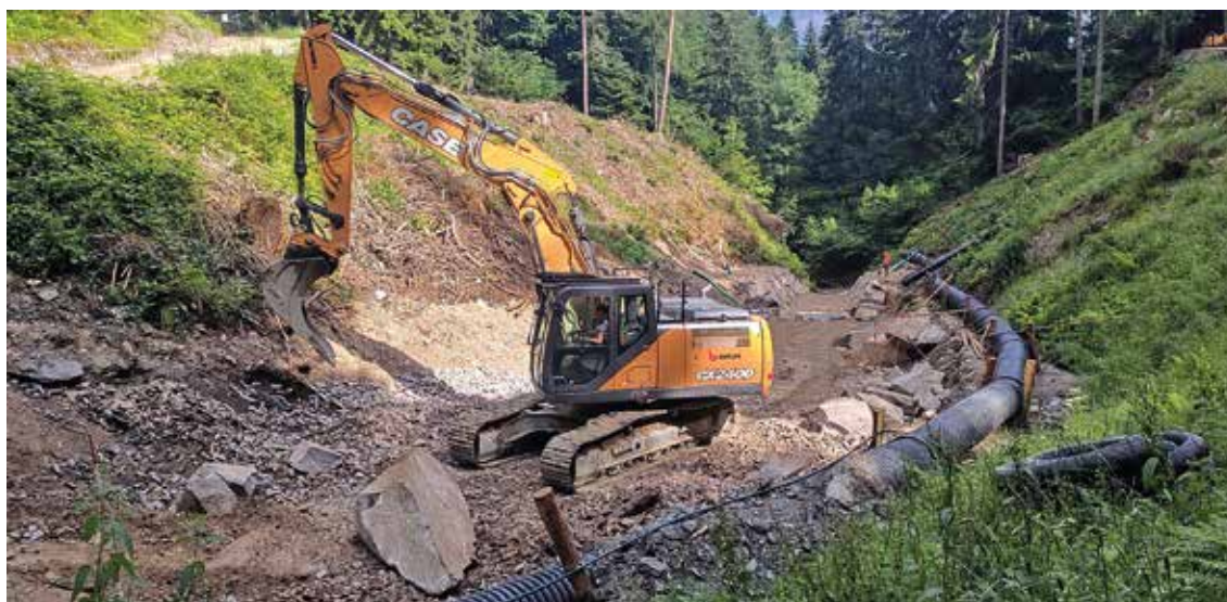
Sistemazione dell'alveo da parte del Servizio Bacini montani
