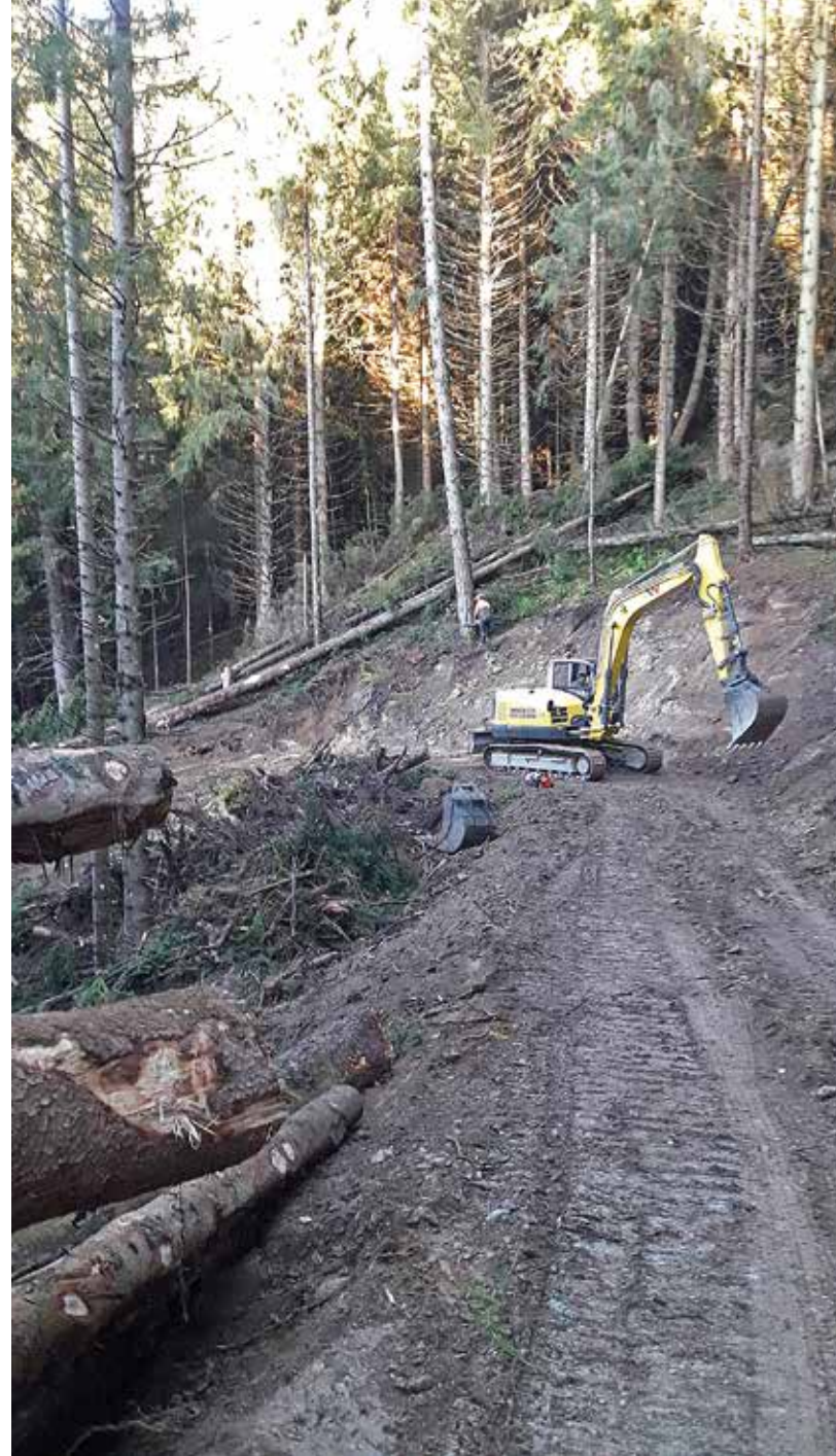
Realizzazione primo tornante
