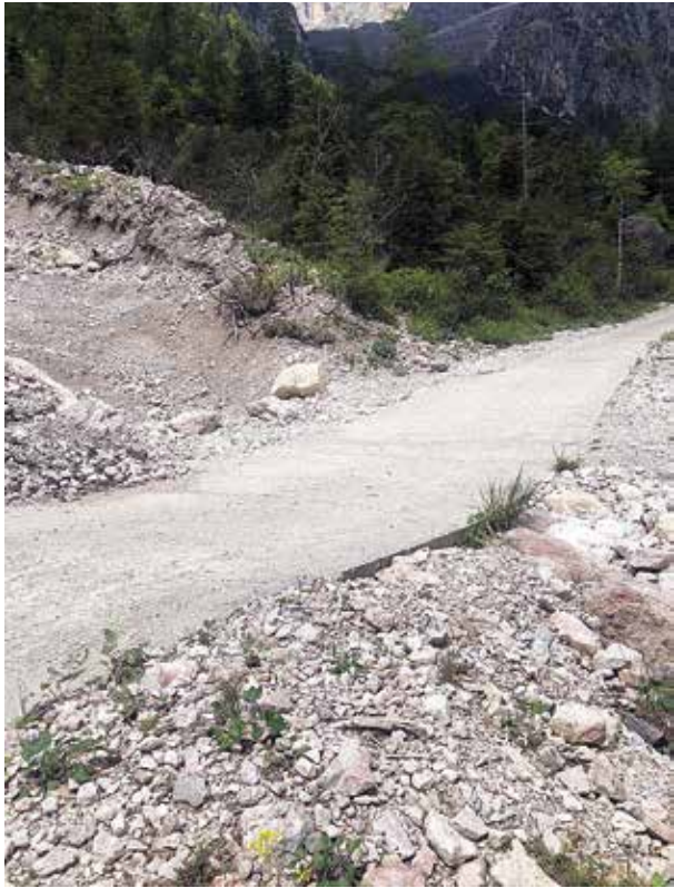
Tratto cementato che svolge la funzione di guado
