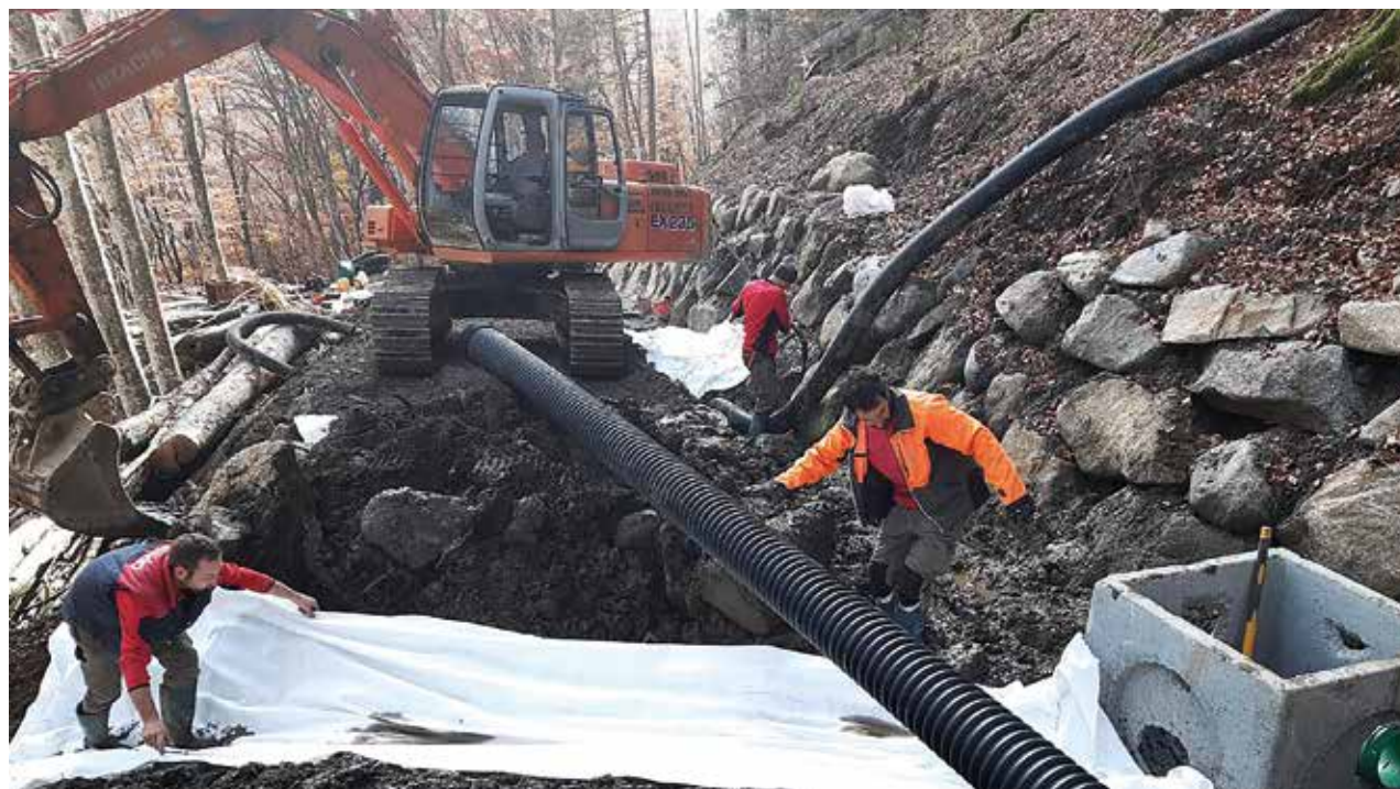
Realizzazione rete drenante e posa del tessuto geotessile
