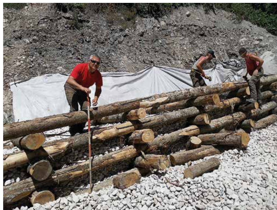
Costruzione arce con legname di castagno
