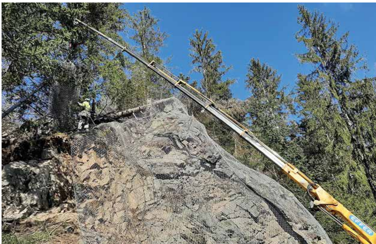
Consolidamento tratto iniziale con reti in aderenza
