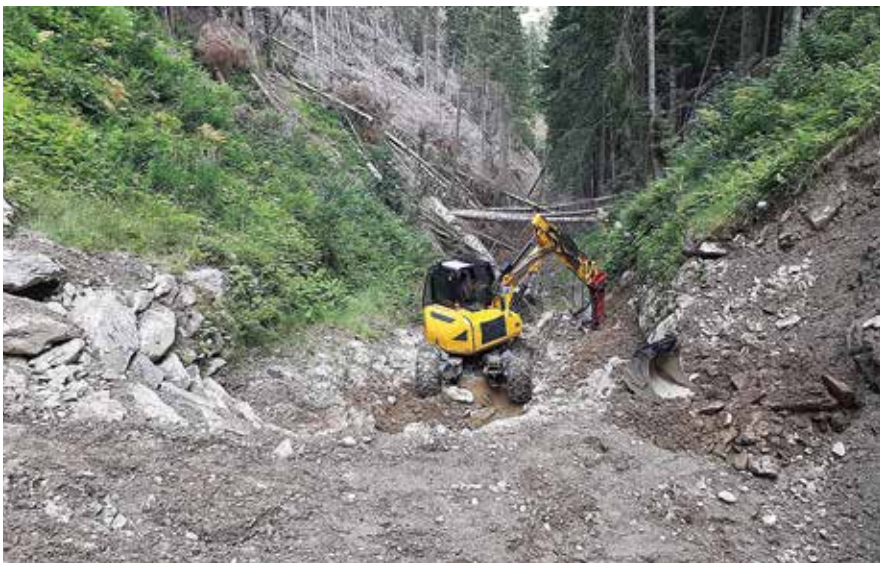
Sistemazione alveo e rifacimento scogliera a sostegno del guado
