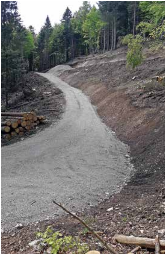
Finitura con ghiaia recuperata in cantiere
