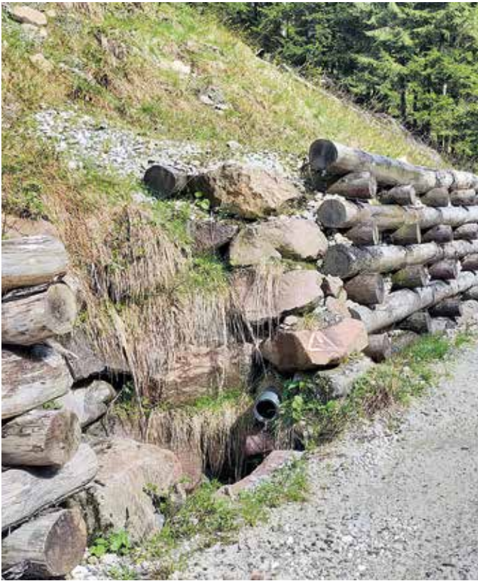
Drenaggio e scarico delle acque
