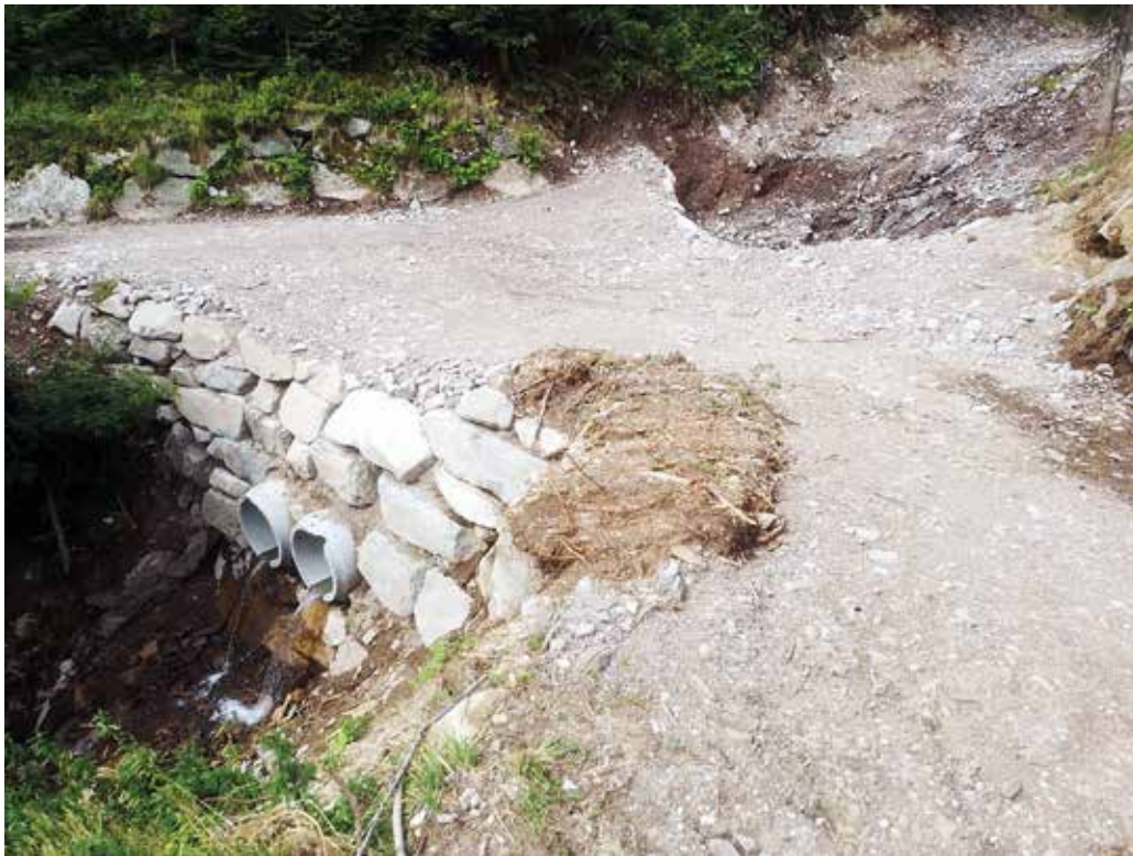
Strada forestale "Fraton di Fornasa" Valfloriana - proprietà comune di Fornace Ripristino transitabilità su 1,1 km e realizzazione tombini+guadi
