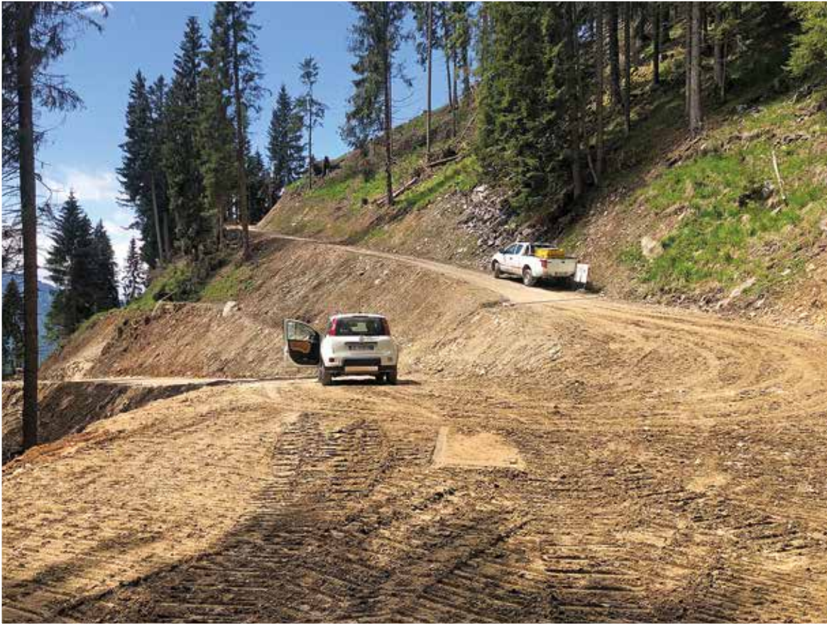
Innesto variante "Redasega - Fedoi" con la nuova strada "Scavalco - Bedolè"
