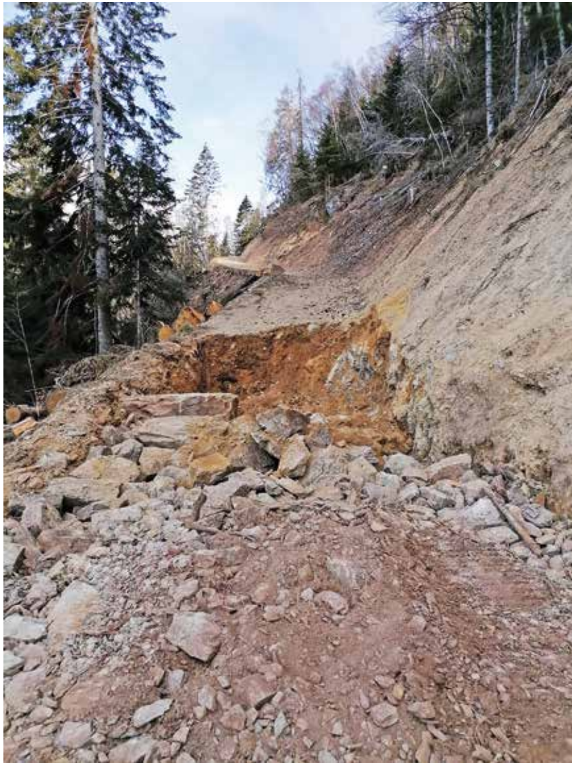
Sistemazione con scogliera del cedimento della rampa a monte, per venute d'acqua
