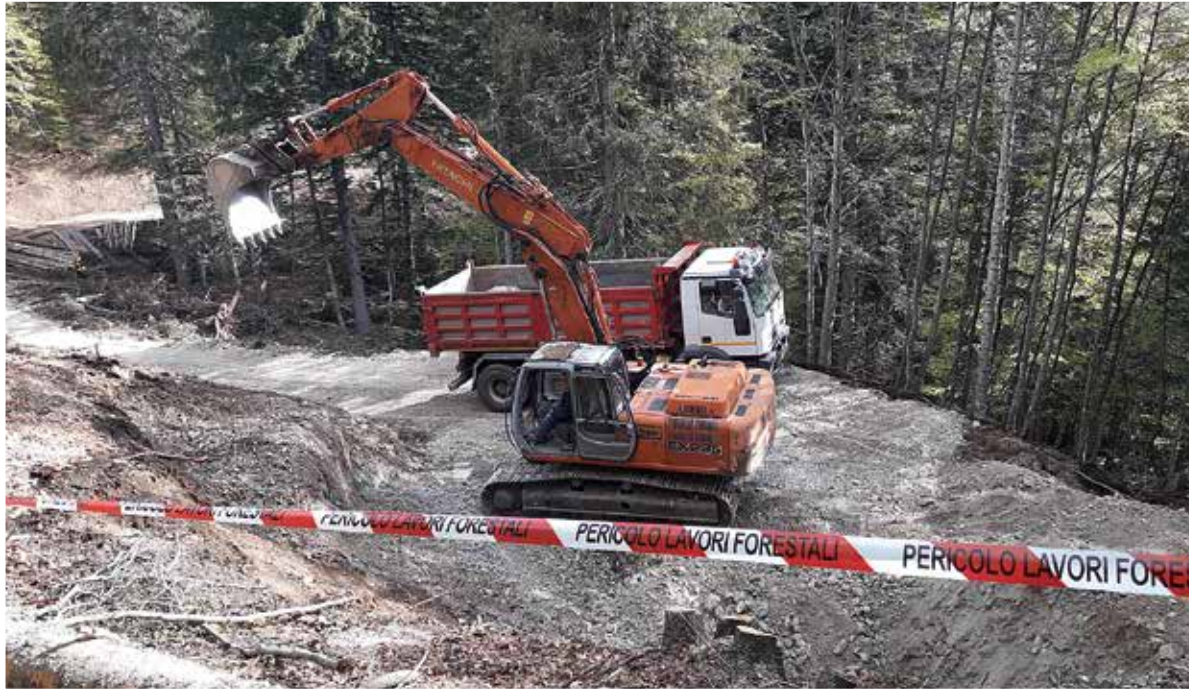
Estrazione materiale nella costruzione del tornante
