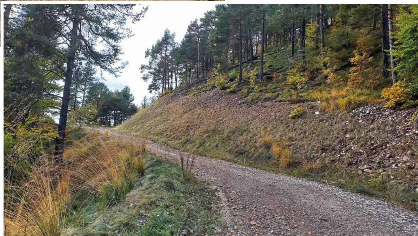
Strada forestale "Cirocol" Baselga di Pinè Adeguamento strada e sistemazione scarpate con posa di tessuto
