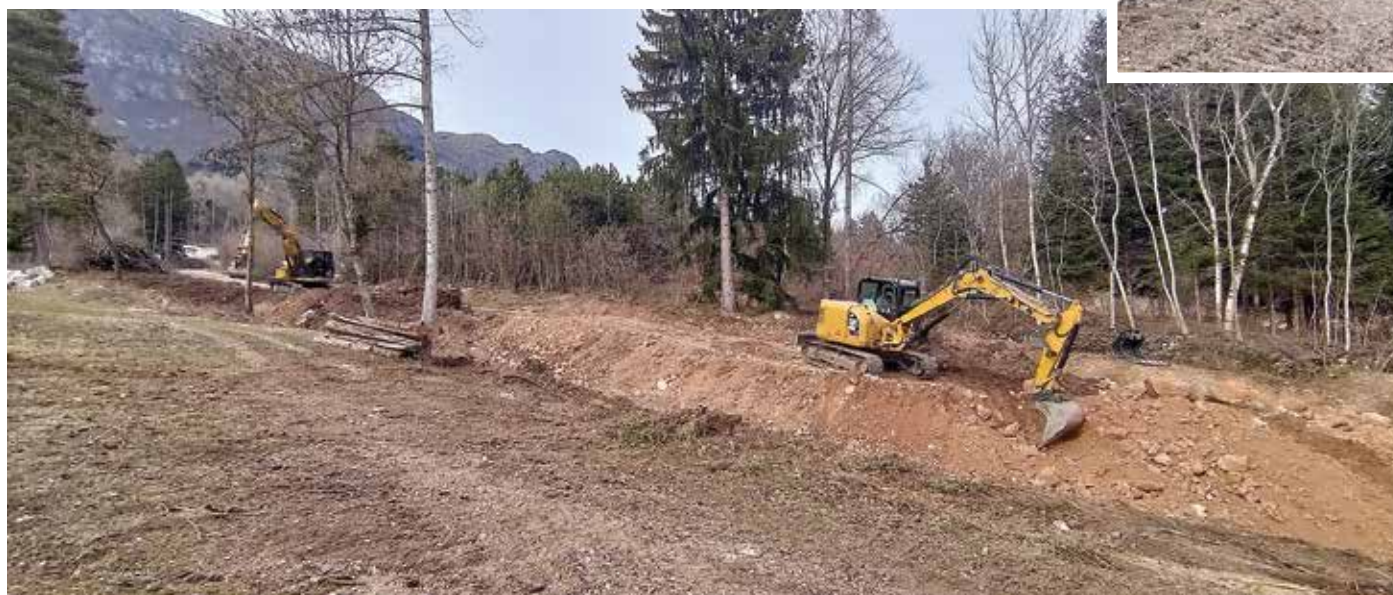
Ripulitura e consolidamento alveo dove erano già presenti alcune briglie
