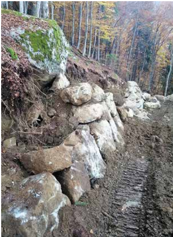
Costruzione scogliera a monte strada
