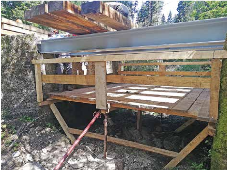
Sottoponte di sicurezza per la posa delle travature in acciaio
