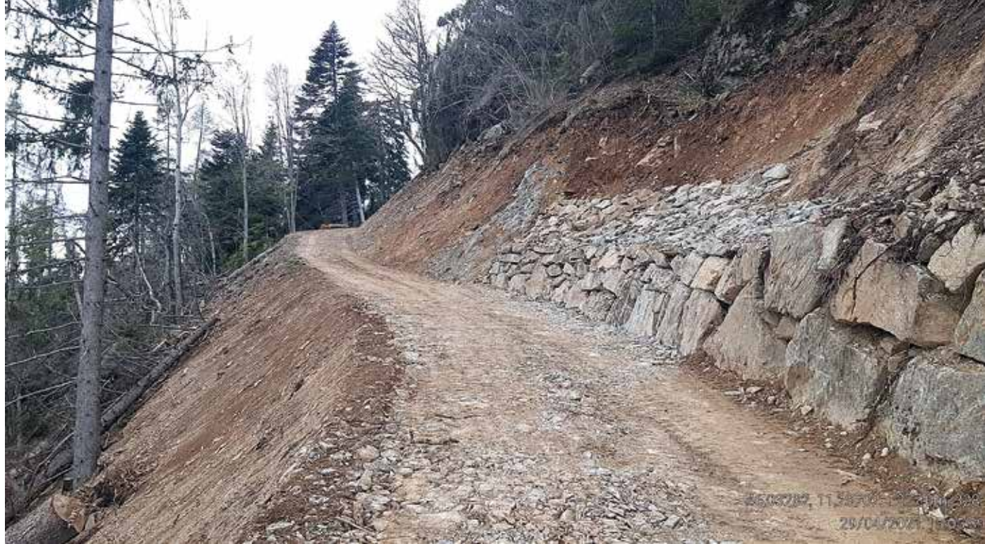
Sistemazione con scogliera del cedimento della rampa a monte, per venute d'acqua
