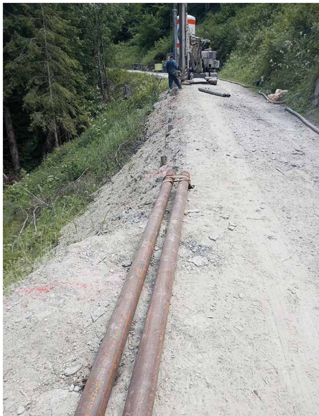
Intervento di consolidamento con micropali
