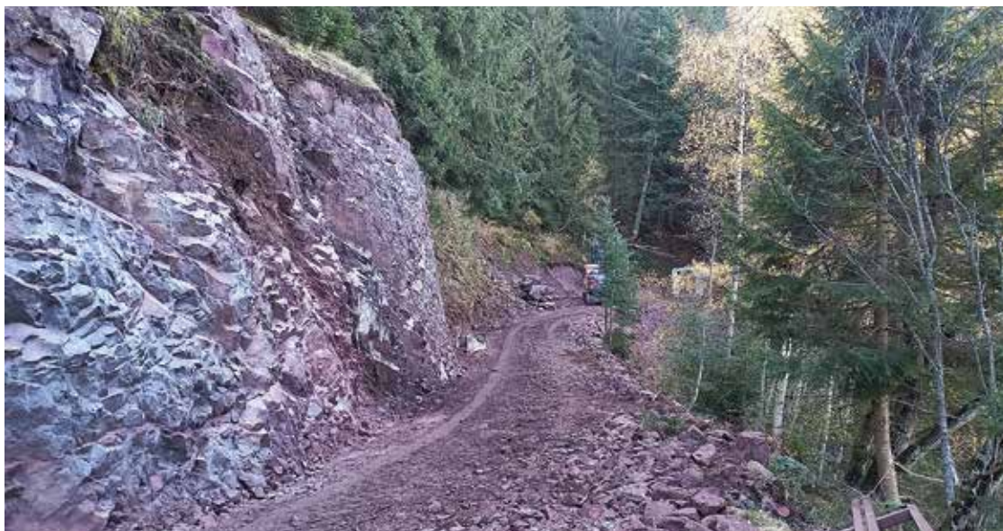
Scavo in roccia per allargamento della sede stradale
