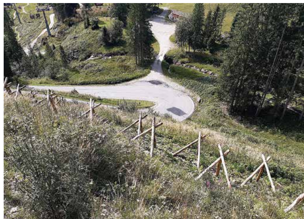
Località Ces rimboschimenti con opere di difesa da valanghe/ungulati
