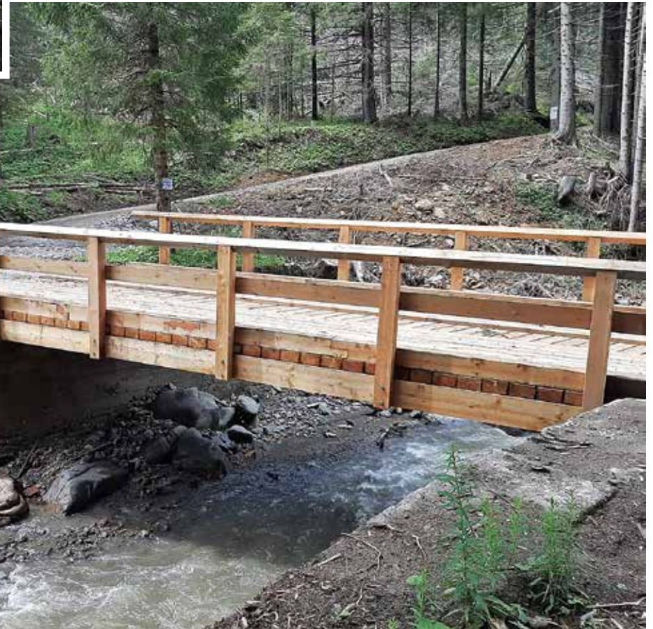
Rifacimento del ponte Mandre sul rio Cavelonte
