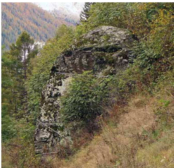
Consolidamento masso pericoloso per il sottostante abitato
