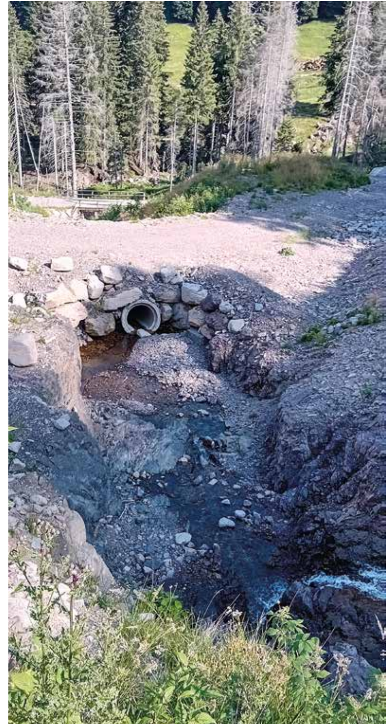
Strada forestale "Fraton di Fornasa" Valfloriana - proprietà comune di Fornace Ripristino transitabilità su 1,1 km e realizzazione tombini+guadi
