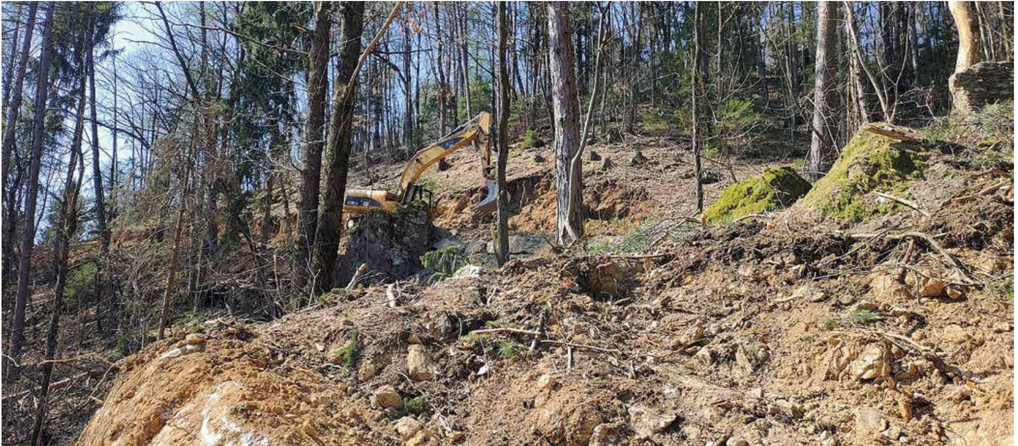
Strada forestale "Costa di Vigalzano" - Pergine Valsugana Realizzazione nuova strada forestale - km 1,05 reti provvisorie di cantiere a protezione della sottostante strada provinciale
