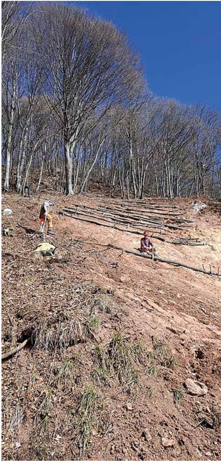
Sistemazione con palizzate
