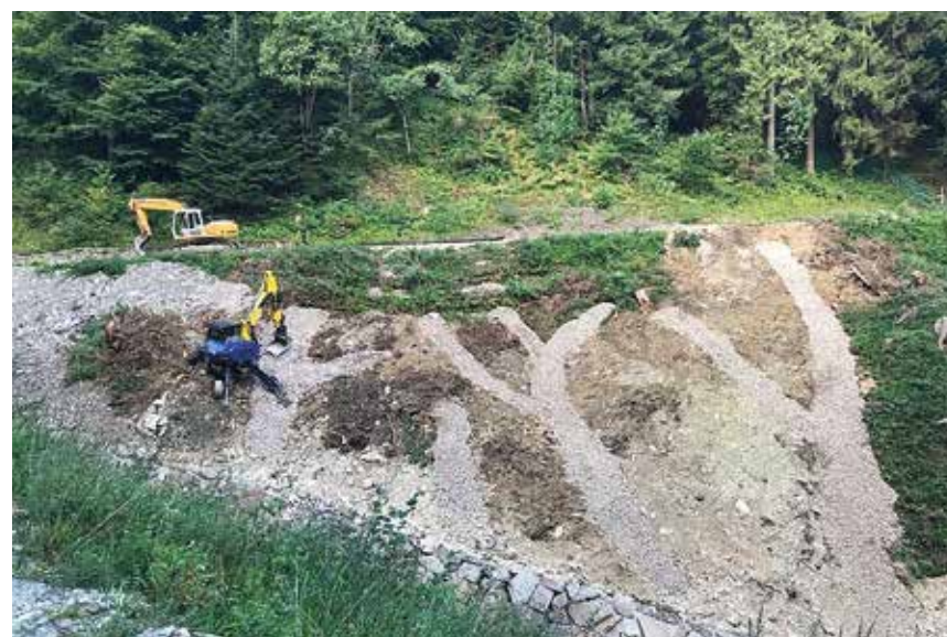
Reticolo di drenaggi per stabilizzare le rampe
