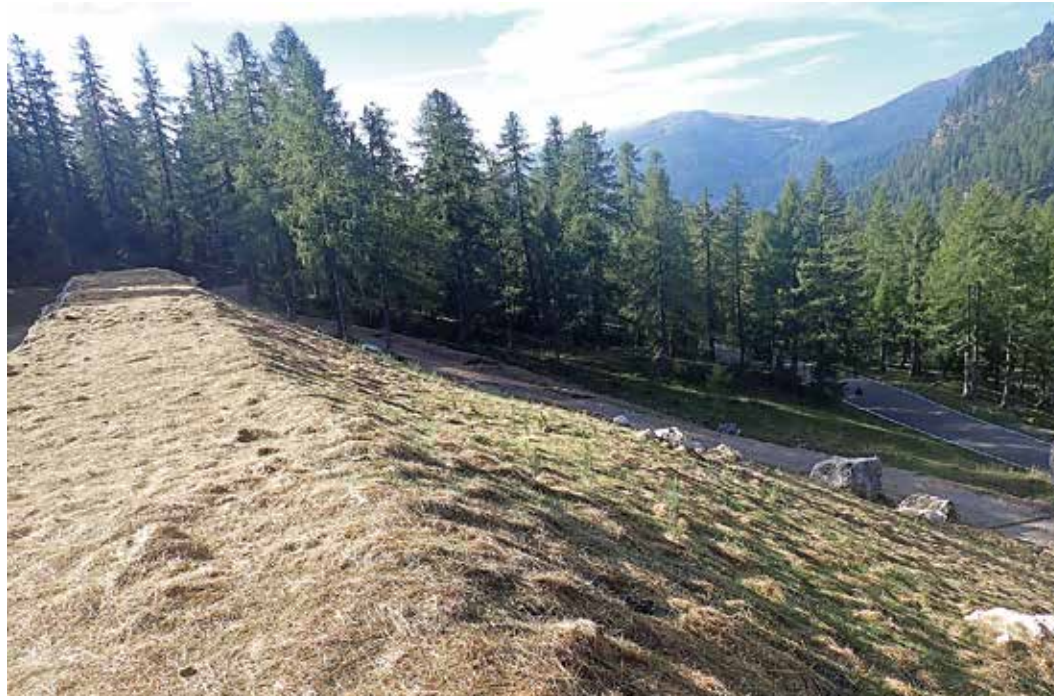
Rimboschimento su vallo paravalanghe strada statale di Passo Rolle
