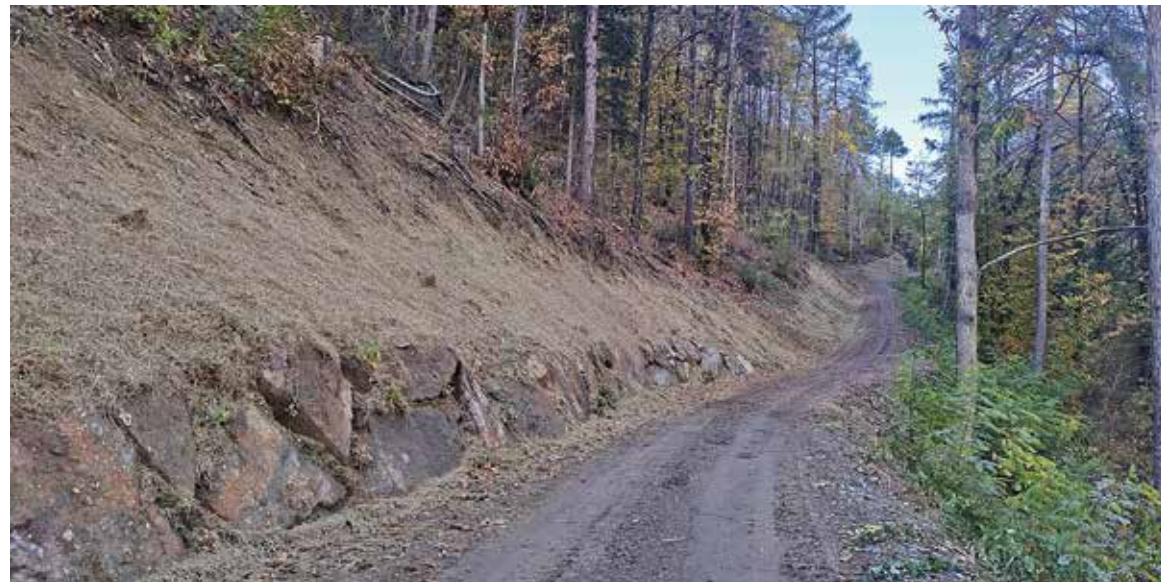
Strada forestale "Costa di Vigalzano" - Pergine Valsugana Realizzazione nuova strada forestale - km 1,05 reti provvisorie di cantiere a protezione della sottostante strada provinciale
