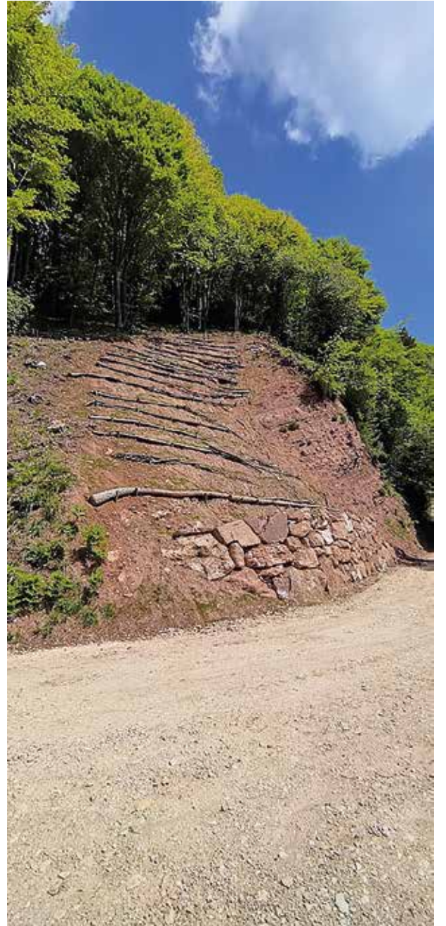
Sistemazione con palizzate
