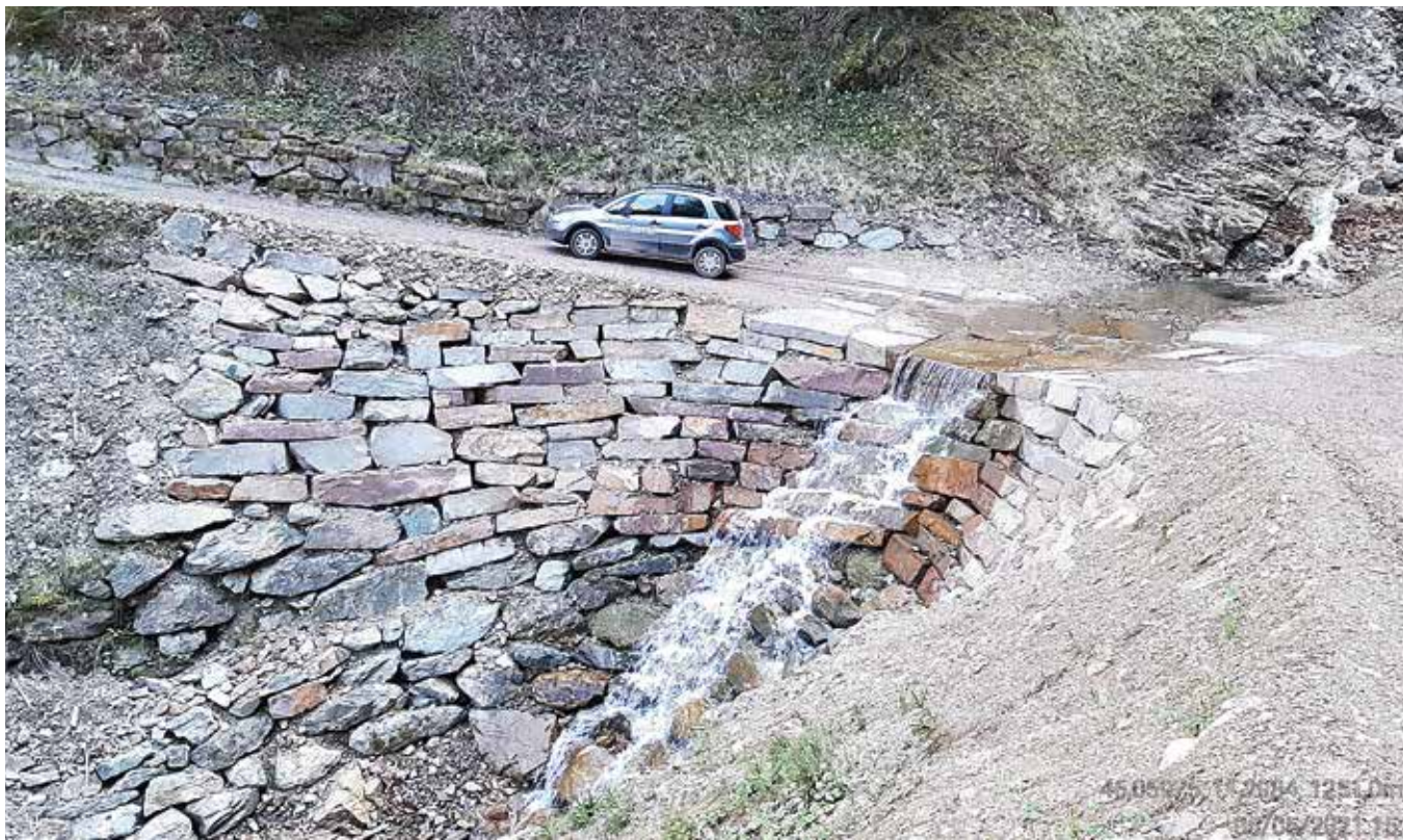
Sistemazione alveo e rifacimento scogliera a sostegno del guado
