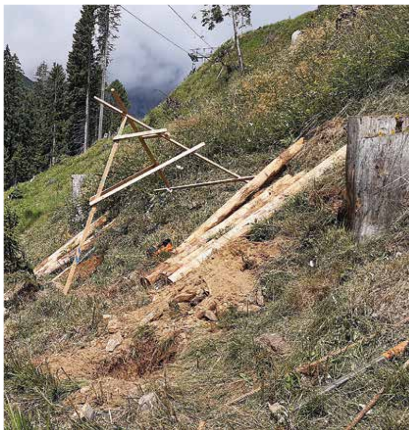
Località Ces rimboschimenti con opere di difesa da valanghe/ungulati
