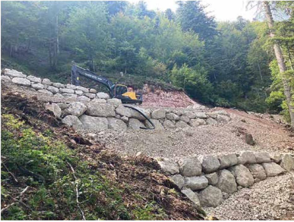
Realizzazione di tre scogliere sovrapposte con regimazione delle acque
