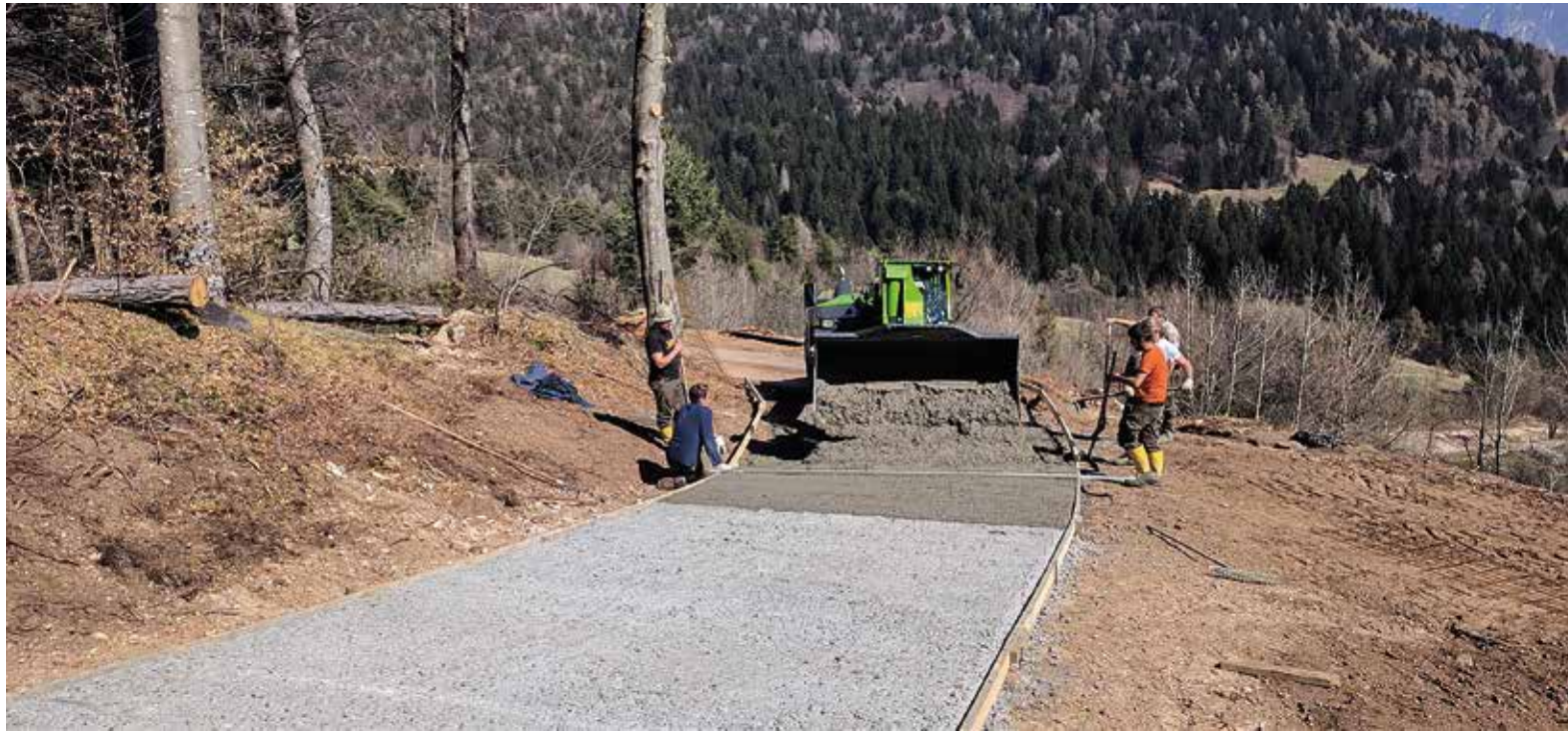
Cementatura tratto ripido iniziale
