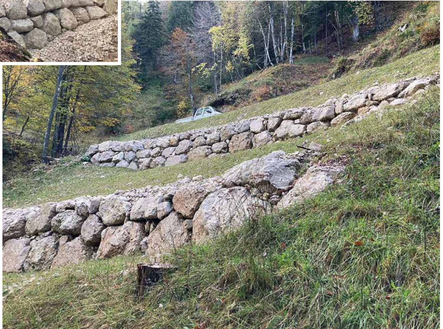
Realizzazione di tre scogliere sovrapposte con regimazione delle acque
