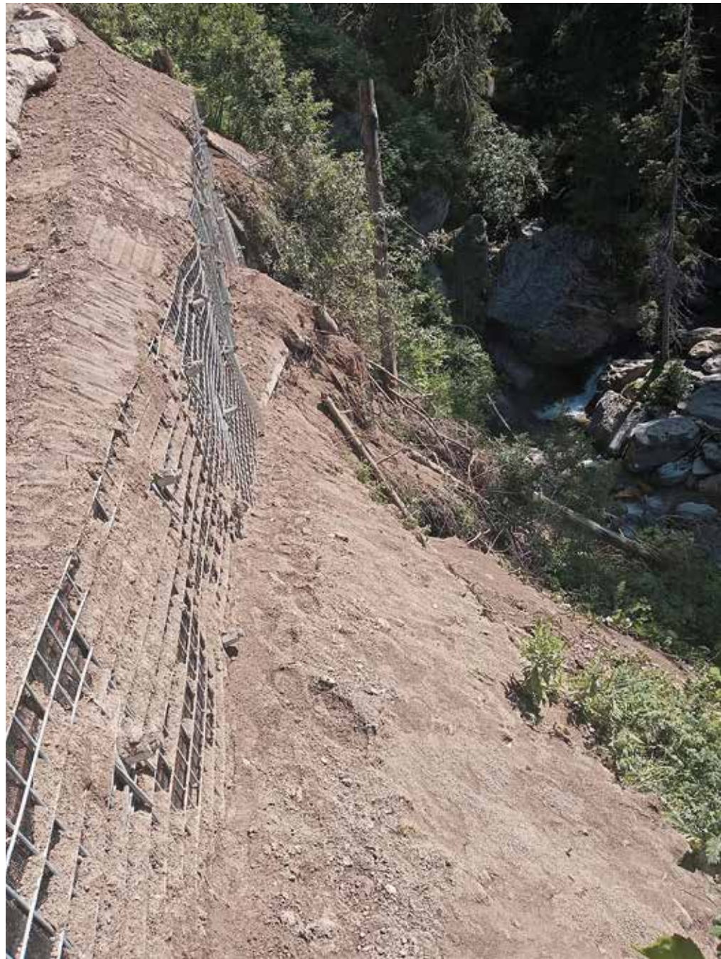
Reti di contenimento trattenute da tiranti infissi nel terreno con chiodature
