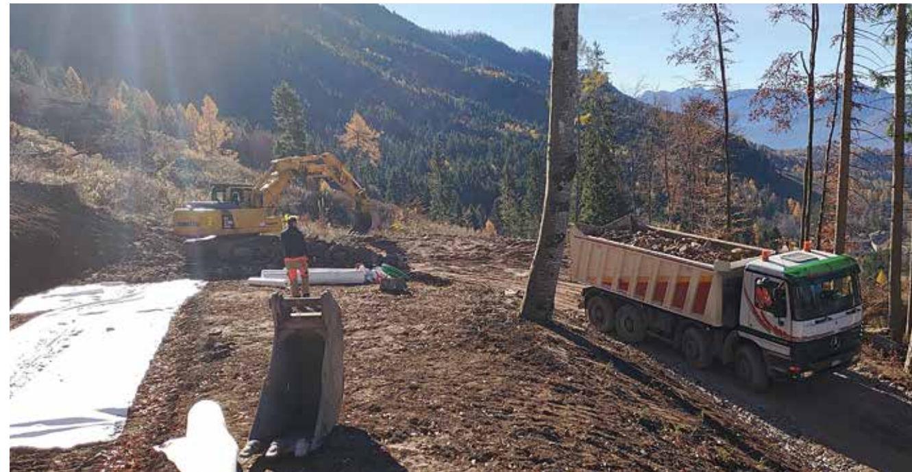
Trincee drenanti e stesura di geotessile per abbondanti venute d'acqua
