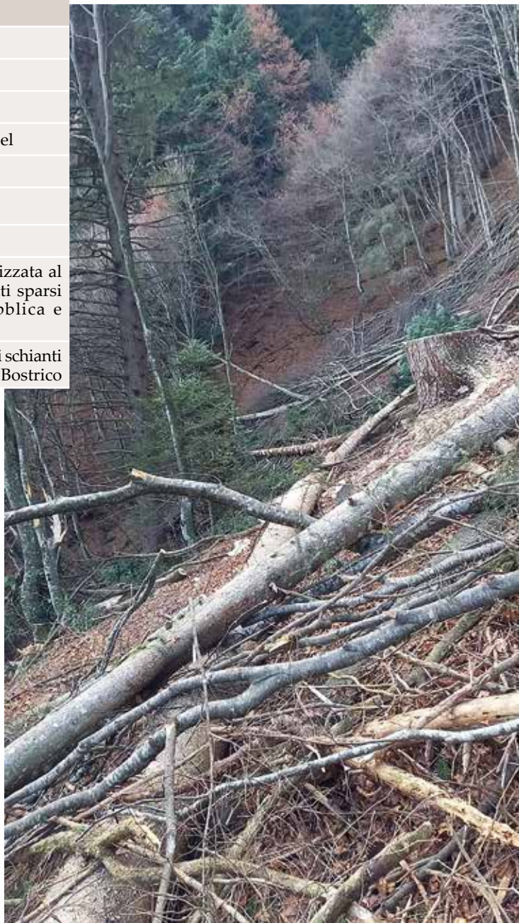
Taglio piante per traccia strada
