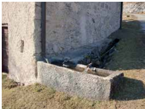
Fig. 6 - abbeveratoio casa Giacomini Slossar , località Cerana, comune di Ragoli, conca di Tione, 2015 - foto Prisca Giovannini
