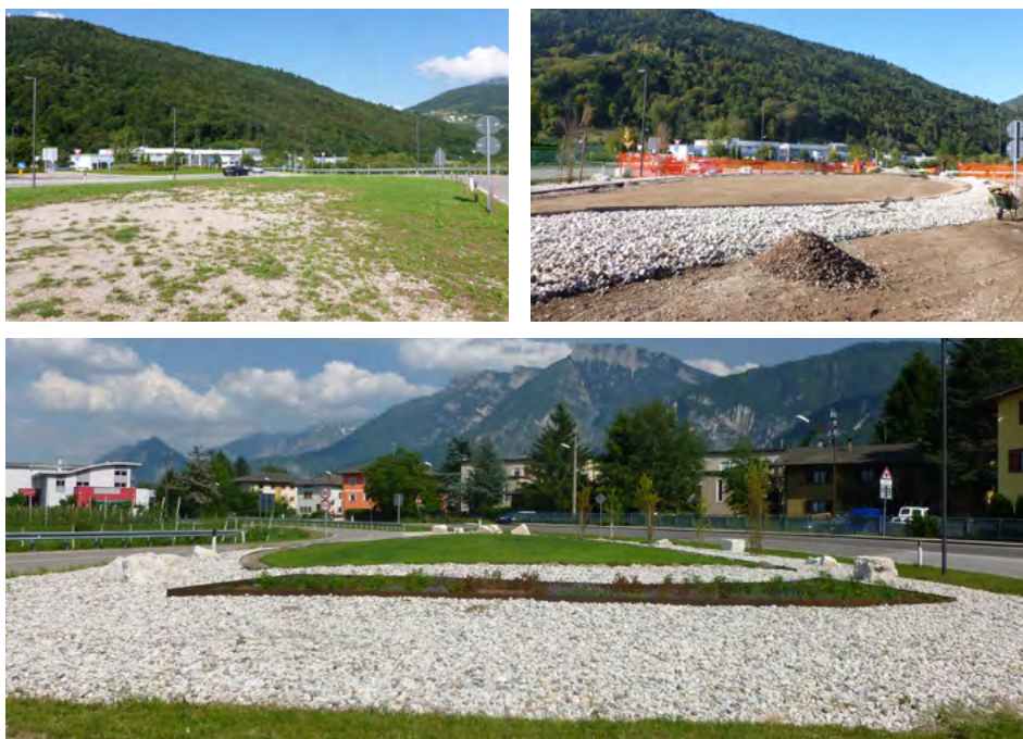
Caldonazzo: sistemazione a verde dell'area inserita nella nuova variante per il lago di Caldonazzo: in sequenza, l'area prima dell'inizio dei lavori, i lavori in corso e la situazione dopo 6 mesi dalla conclusione
