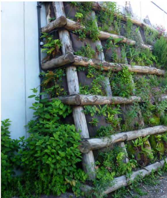
Realizzazione di "verde verticale", per il MUSE; in sequenza: la parete nuda in calcestruzzo, la messa in opera della struttura in legno, le piantine a dimora nel terriccio contenuto nel telo e l'opera ad un anno dalla realizzazione
