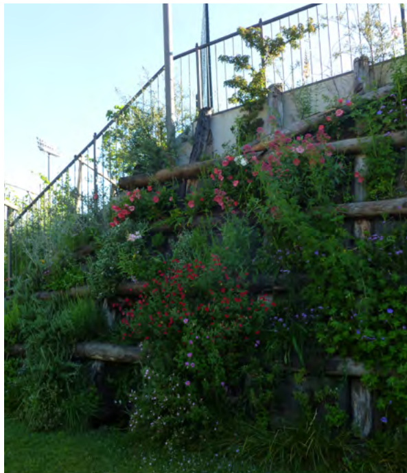
Realizzazione di "verde verticale", per il MUSE; in sequenza: la parete nuda in calcestruzzo, la messa in opera della struttura in legno, le piantine a dimora nel terriccio contenuto nel telo e l'opera ad un anno dalla realizzazione
