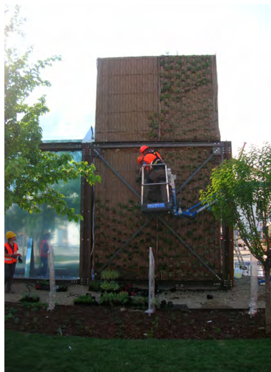
Le pareti a verde verticale in corso di realizzazione all'EXPO di Milano
