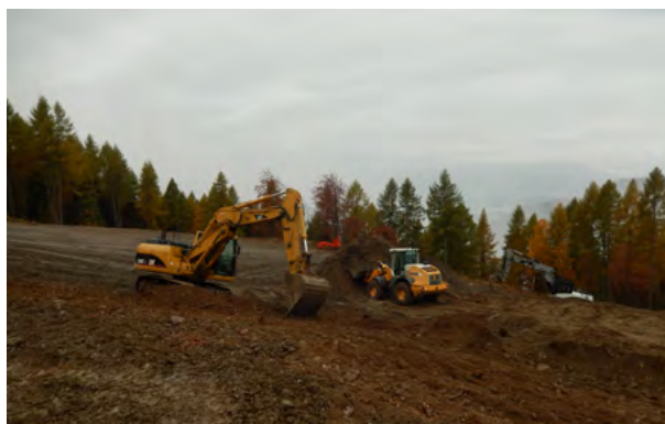
Riprofilazione dell'area di intervento nei pressi dello "Chalet" in località Kamauz, con l'utilizzo di escavatore
