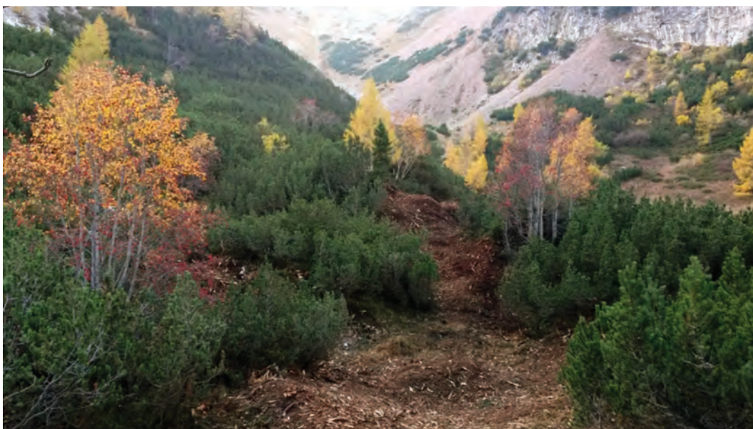
Figura 39 Fase iniziale di apertura della mugheta da parte di un escavatore munito di trinciatrice. Con il taglio si cercherà di dare spazio alle latifoglie presenti, costituite in questo caso dal Sorbo degli uccellatori. Alla fine dei lavori il Pino mugo dovrà rimanere su non più del 30-40% della superficie (foto Marco Faes, 25.10.2013).
