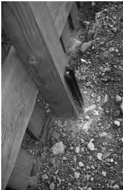
Talvolta si rende necessario per alcuni tratti realizzare sostegni artificiali.
