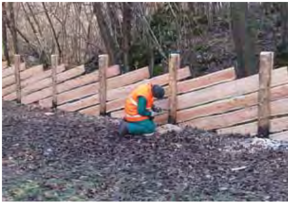
5. Realizzazione di fori passanti in corrispondenza dell'altezza media delle assi, per irrigidire la struttura.
