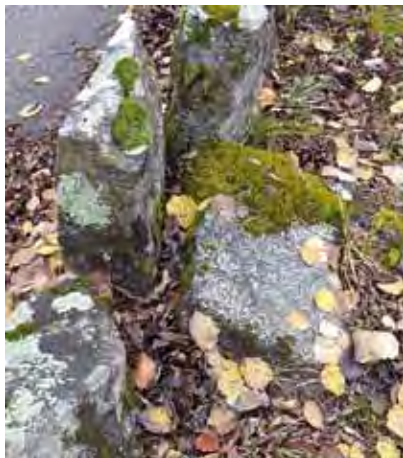
I traumi meccanici accidentali degli automezzi hanno spezzato le lastre.
