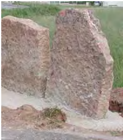
Le superfici a vista non vanno sabbiate. Devono essere evitate posa in opera e risarciture a cemento.
