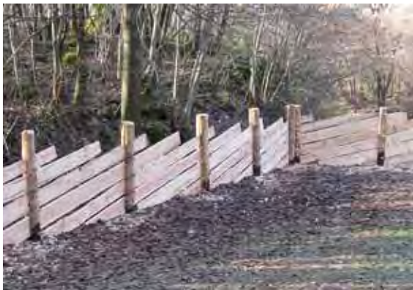
6. Ribattitura dei cavicchi di pari diametro già predisposti all'uso.
