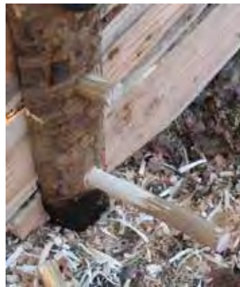
5. Realizzazione di fori passanti in corrispondenza dell'altezza media delle assi, per irrigidire la struttura.
