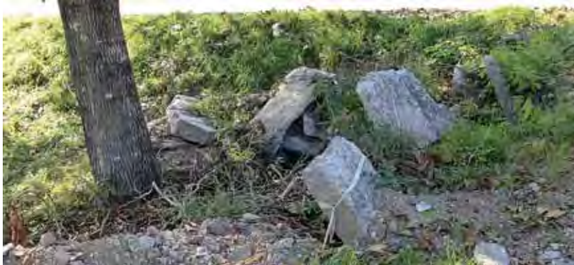
Le radici delle piante e i rullaggi delle carreggiate hanno inclinato l'allineamento.
