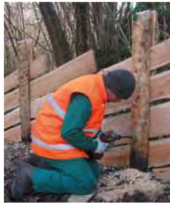
5. Realizzazione di fori passanti in corrispondenza dell'altezza media delle assi, per irrigidire la struttura.
