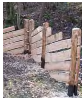
4. Posizionamento della seconda fila di smezzole ben accostate alle assi, e in corrispondenza delle controfaccie esistenti.
