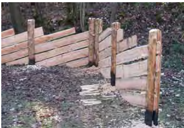
4. Posizionamento della seconda fila di smezzole ben accostate alle assi, e in corrispondenza delle controfaccie esistenti.
