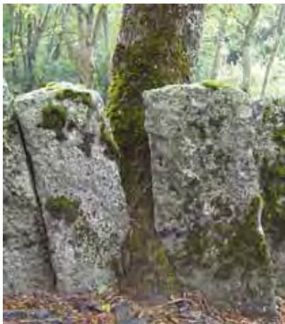
Le radici delle piante e i rullaggi delle carreggiate hanno inclinato l'allineamento.
