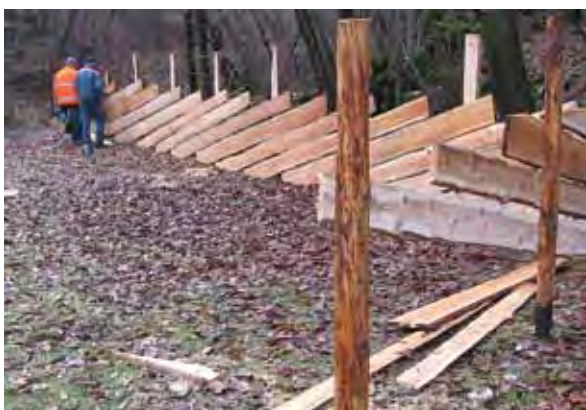
2. All'allineamento della prima fila di smezzole, conficcandole nel terreno a interasse di circa 2 m l'una dall'altra.
