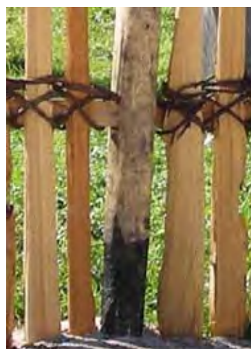
La parte del montante a contatto con il suolo va abbruciata, come in questi esempi. (2009-2010, foto Giovanni Giovannini)
