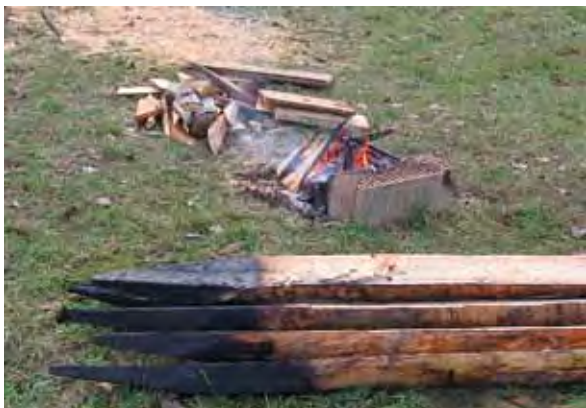
1. Abbruciatura delle estremità inferiori delle smezzole.
