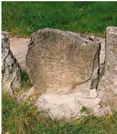
Le superfici a vista non vanno sabbiate. Devono essere evitate posa in opera e risarciture a cemento.
