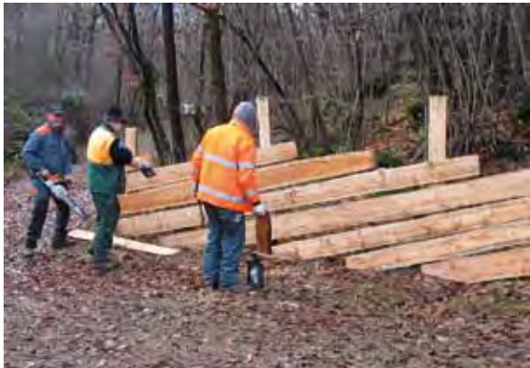
3. Chiodatura delle assi inclinate rispetto al terreno sulla faccia piana delle smezzole.
