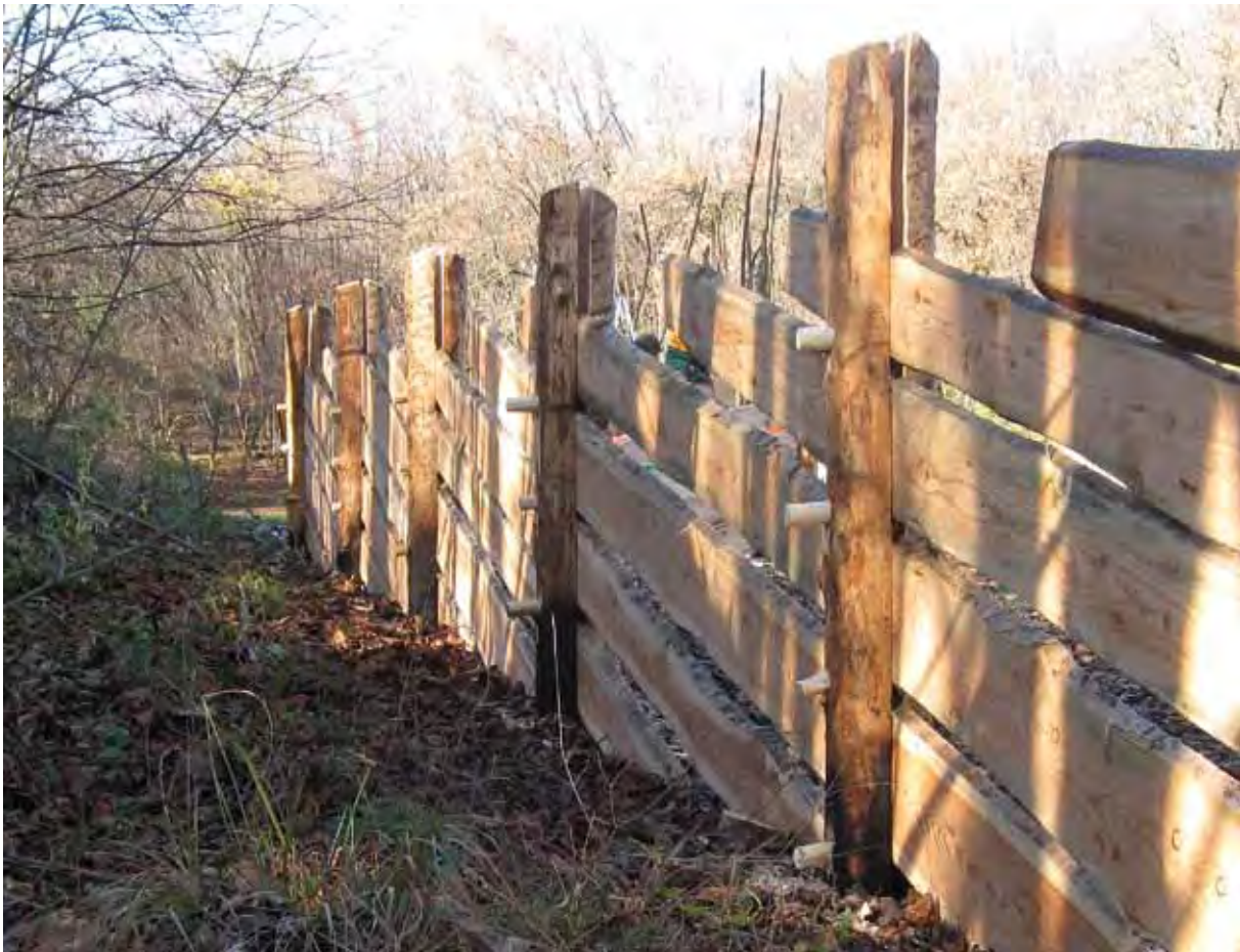
6. Ribattitura dei cavicchi di pari diametro già predisposti all'uso.
