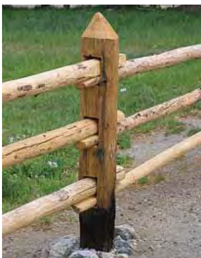
La parte del montante a contatto con il suolo va abbruciata, come in questi esempi. (2009-2010, foto Giovanni Giovannini)
