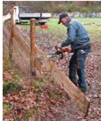
2. All'allineamento della prima fila di smezzole, conficcandole nel terreno a interasse di circa 2 m l'una dall'altra.
