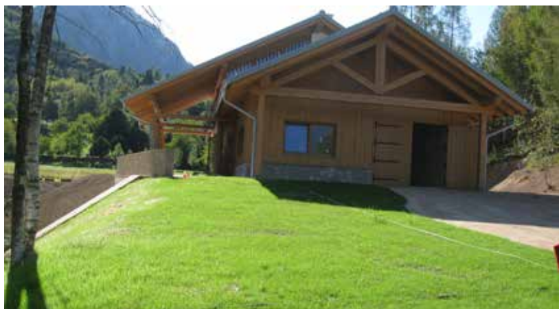
La nuova struttura realizzata e progettata a cura del Servizio Foreste e fauna verrà adibita in parte a laboratorio e aule didattiche, in parte a magazzino
