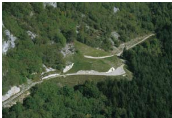
Vascone antincendio a Vezzano
