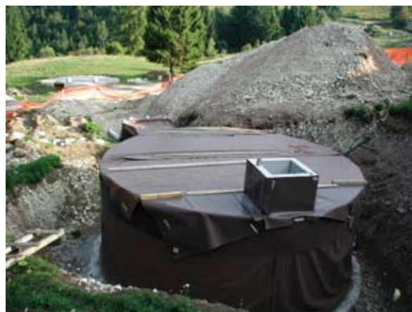
Vascone circolare sul Monte Lefre, in fase di costruzione
