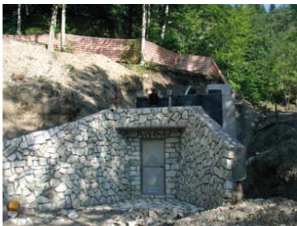
Particolare esterno della cabina di manovra
