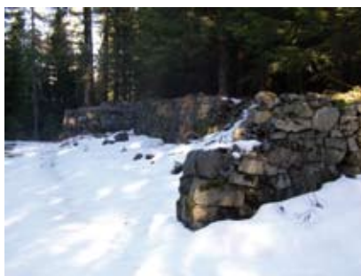
I ruderi dell'antica casera come si presentavano nel 2004, prima dell'inizio lavori
