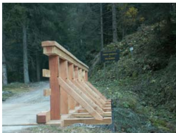
Particolare del parapetto
