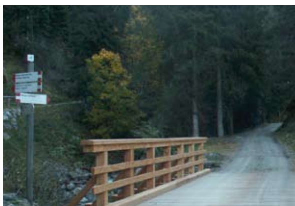
Il ponte Fiamena
