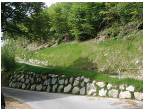
Particolare della sistemazione della scarpata a valle
