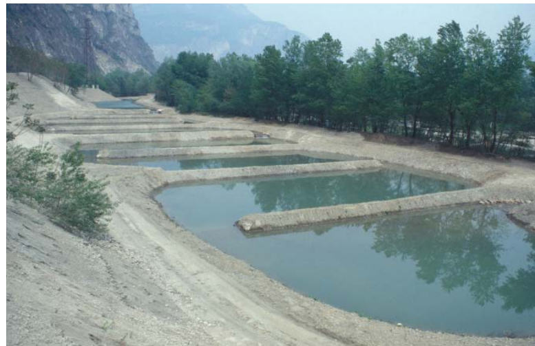
Laguna per la depurazione biologica: appena realizzata nel maggio 1997 (sopra) e dopo tre mesi di funzionamento (sotto)
