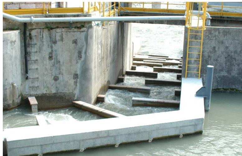
Passaggi per pesci sul Fiume Adige presso lo sbarramento di Ala (sopra), e sul Torrente Fersina alla confluenza con l'Adige a Trento (sotto).
