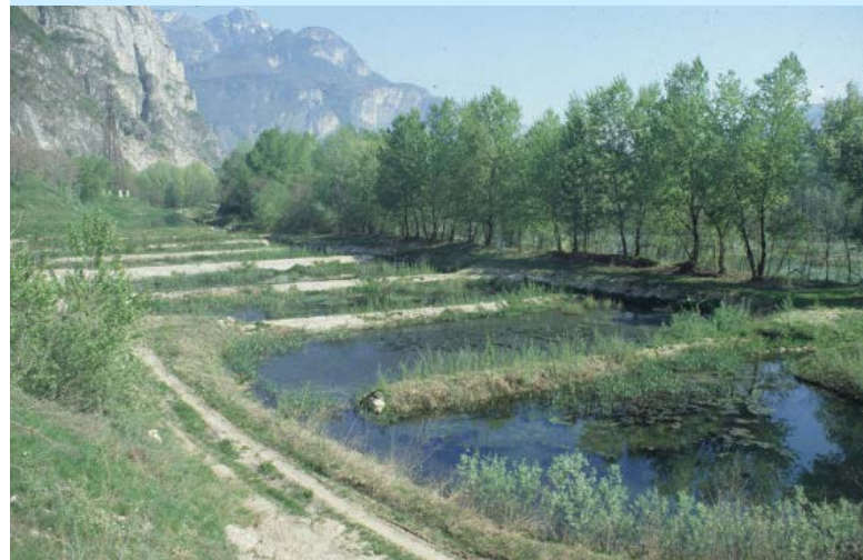
Laguna per la depurazione biologica: appena realizzata nel maggio 1997 (sopra) e dopo tre mesi di funzionamento (sotto)
