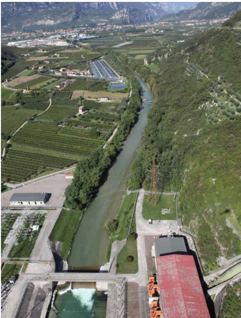
La centrale della "Brossera".
