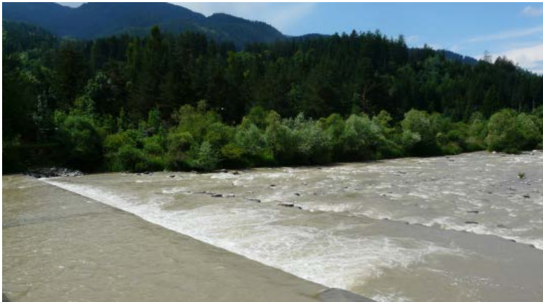
Anomala torbidità del Torrente Avisio a Masi di Cavalese, durante la pulizia periodica del bacino idroelettrico di Pezzè di Moena. Per contenere la torbidità, la pulizia viene effettuata in periodo di morbida e con gradualità.
