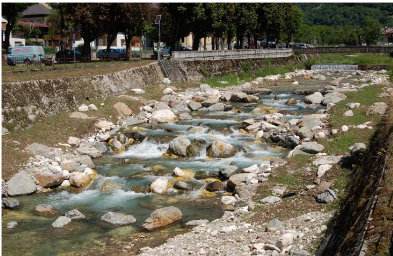
Briglie trasformate in rapide artificiali per consentire la risalita delle trote: sul Fiume Sarca a Ceniga (sopra), e sul Torrente Cison a Fiera di Primiero (sotto).
