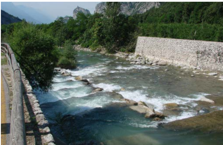
Briglie trasformate in rapide artificiali per consentire la risalita delle trote: sul Fiume Sarca a Ceniga (sopra), e sul Torrente Cison a Fiera di Primiero (sotto).
