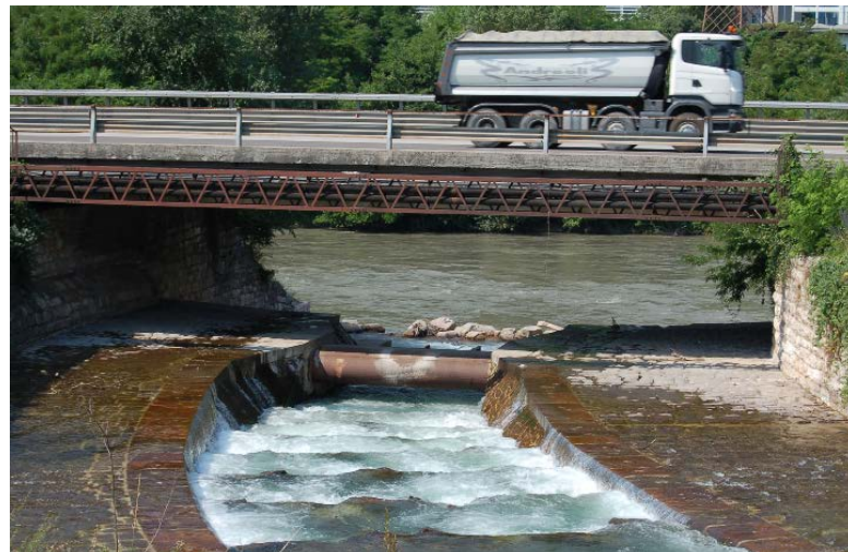
Passaggi per pesci sul Fiume Adige presso lo sbarramento di Ala (sopra), e sul Torrente Fersina alla confluenza con l'Adige a Trento (sotto).
