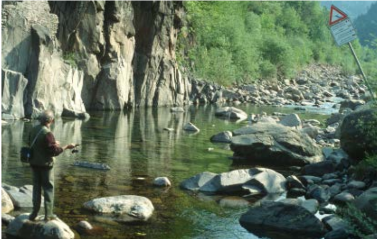
Cartello di pericolo per piene improvvise, posto a valle di una diga.
