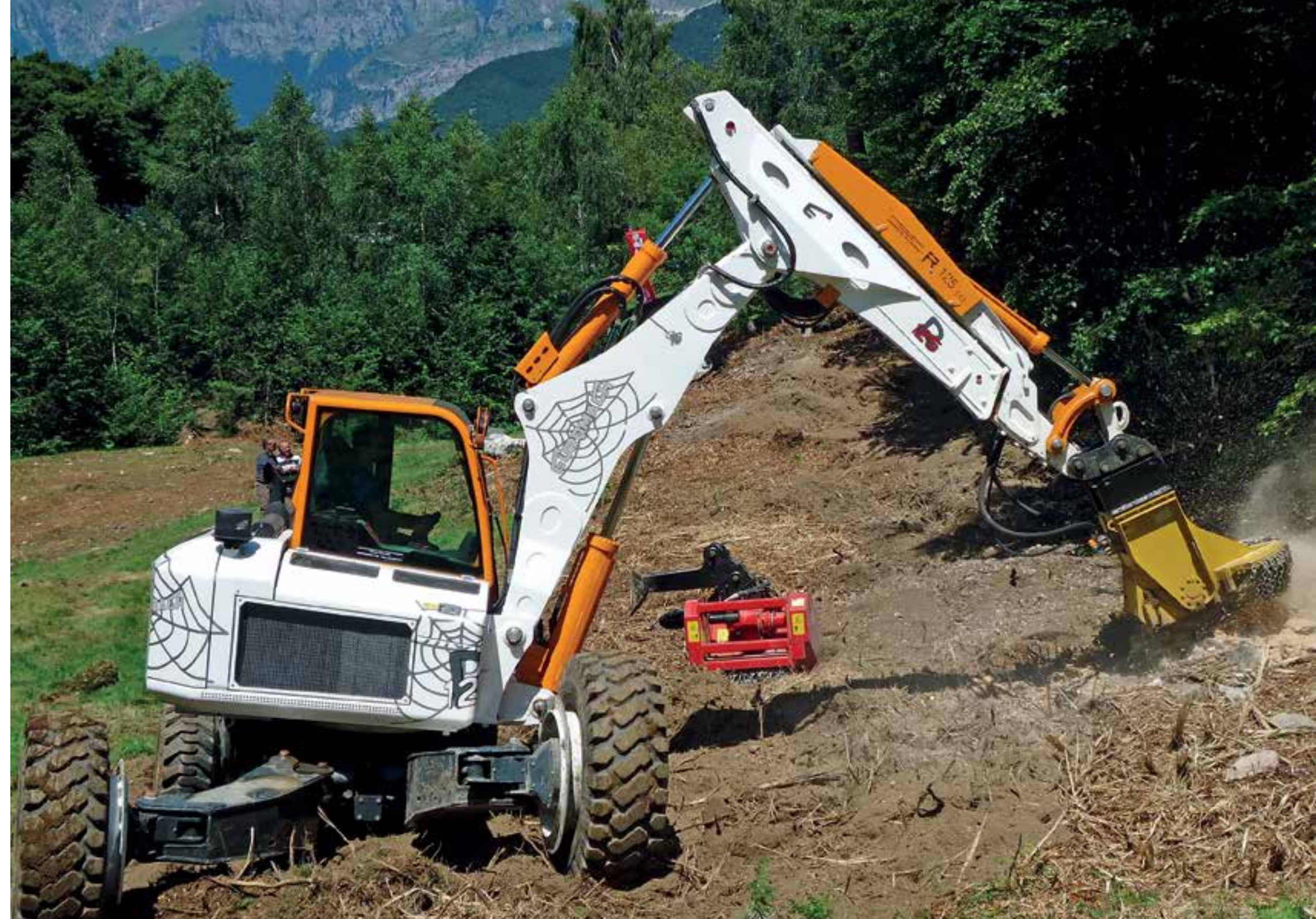
Trinciatura di ceppaie per ampliamento di un pascolo. Foto Giovanni Giovannini, 2014 Ausfräsen von Baumstümpfen zur Erweiterung einer Weide
