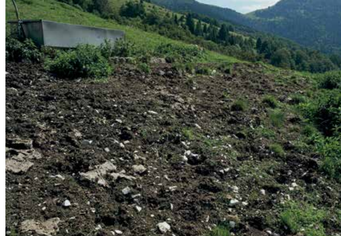
Abbeveratoio posizionato in un luogo errato, senza selciato alla base. Tränke falsch positioniert, ohne Steinlage als Untergrund.
