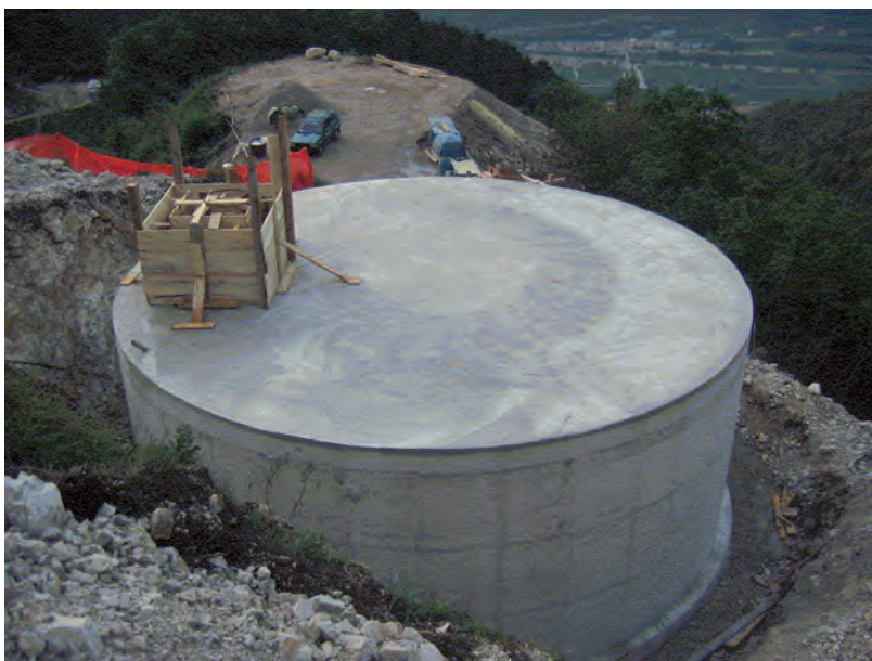
Figura 8.6 - Serbatoio interrato in calcestruzzo in fase di costruzione
