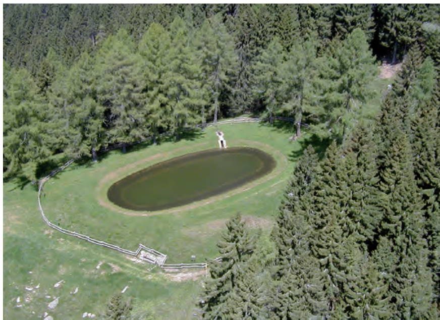
Figura 8.7 - Bacino di accumulo a cielo aperto
