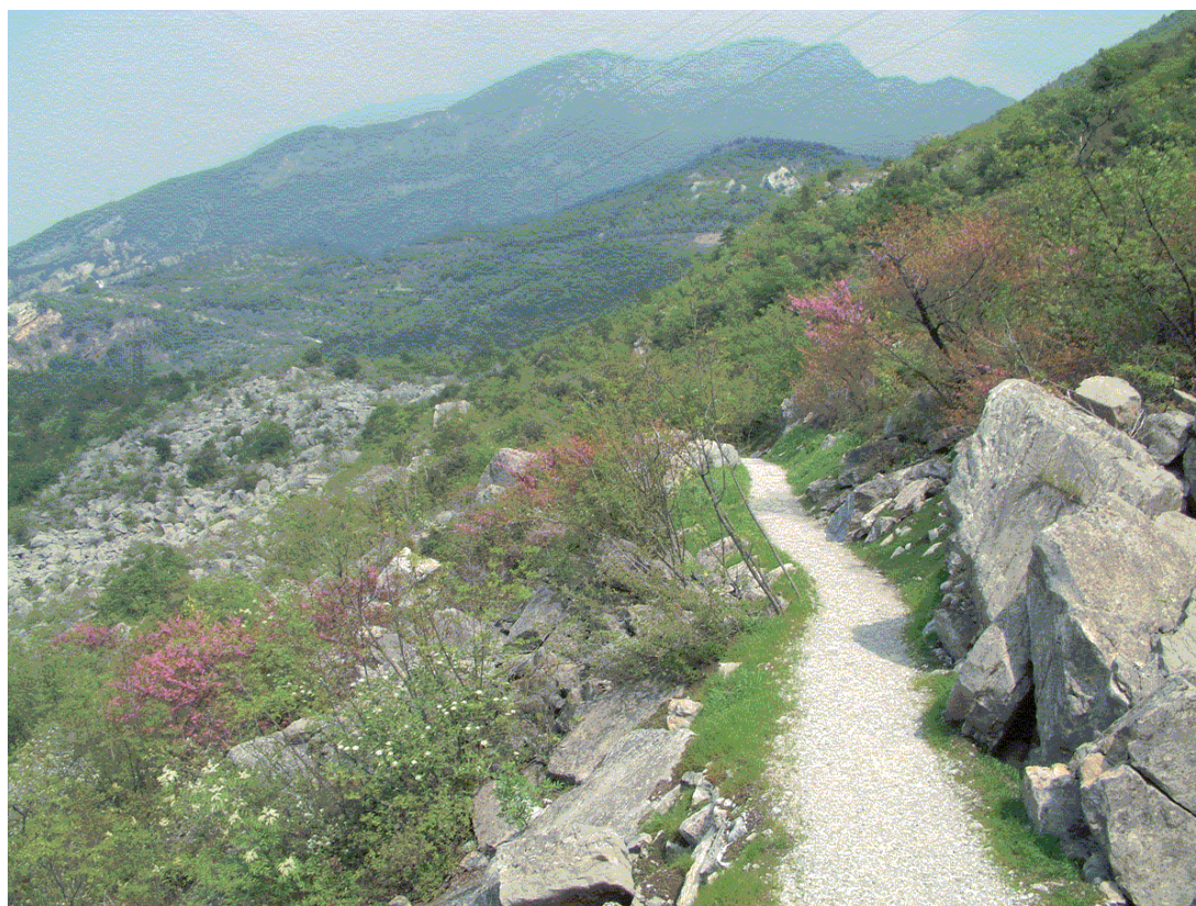
Figura 8.3 - Sentiero con finalità antincendio
