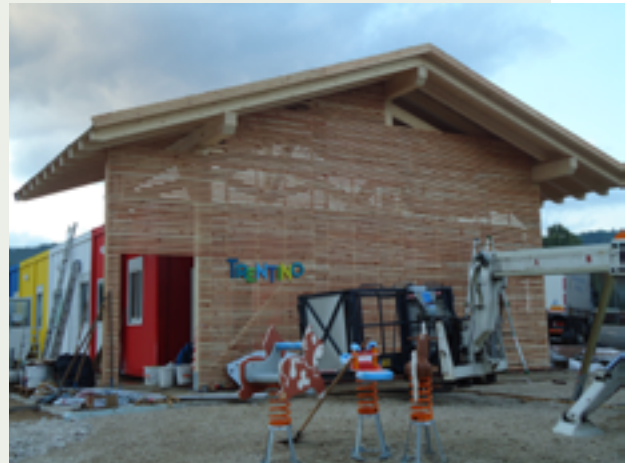
La scuola temporanea in fase di costruzione
