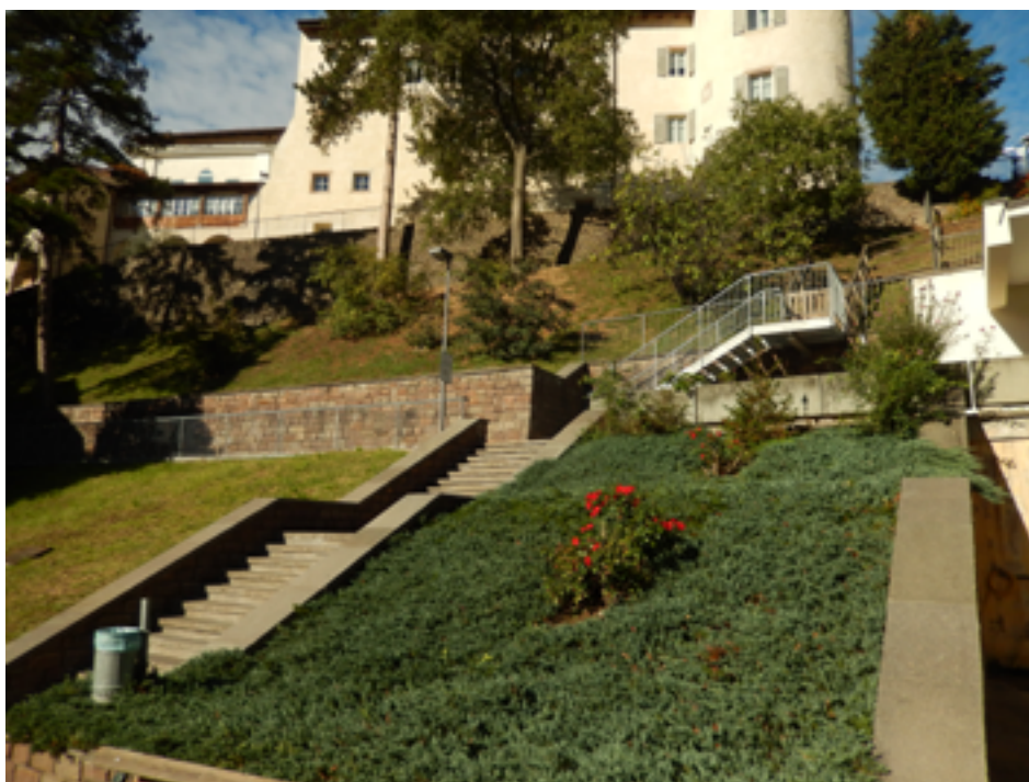
Ripristino della scarpata a valle dell'edificio della Fondazione E. Mach a San Michele all'Adige: il risultato dopo i lavori di asportazione della vegetazione preesistente e rimodellazione del pendio
