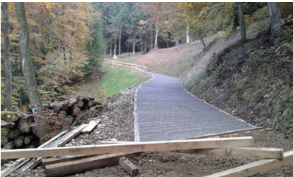
I tratti più ripidi sono stati cementati
