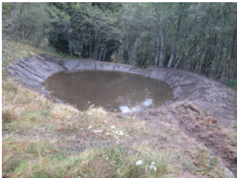
Il sito Stabli durante l'esecuzione dei lavori
