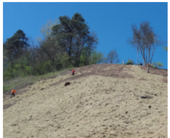
Particolare del versante dopo la pacciamatura di fieno e la semina del miscuglio di specie erbacee di provenienza locale
