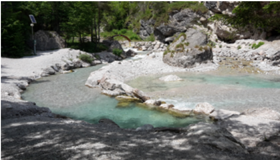
Opera di presa per l'alimentazione del centro ittologico in località Molin dei Mori in comune di Molveno: il Servizio ha ripristinato la pista di accesso per consentire la manutenzione della condotta
