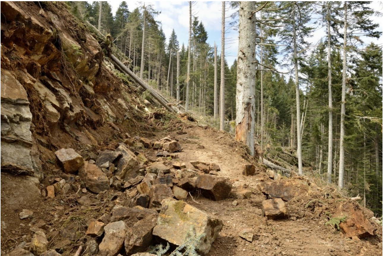
Fig. 7.1: Strada forestale danneggiata in Val Cavelonte (fonte: Alessandro Gadotti).
