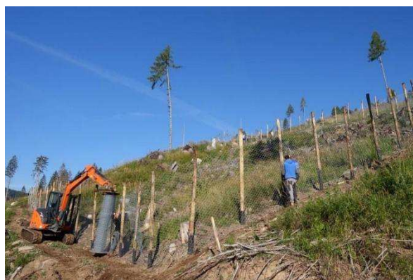
Figura 37 - Realizzazione di recinzioni per la protezione dal cervo dei rimboschimenti in località Bocche, F.D. di Paneveggio
